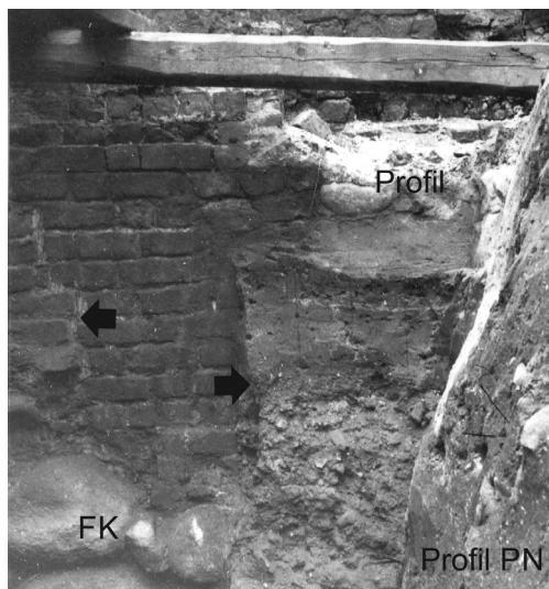
Il. 23. Widok odsłoniętego lica muru filara oraz profil ziemny we wnętrzu arkady.
